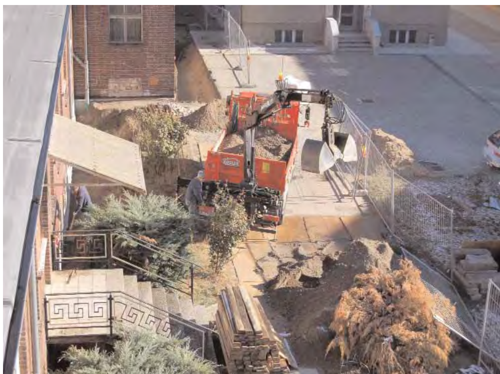
Aushebung des Erdreiches am Altbau, November 2006
