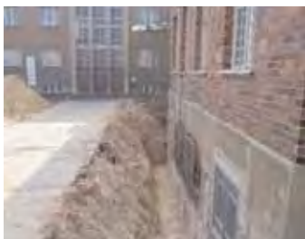
Freigelegtes Fundament des Altbaus
