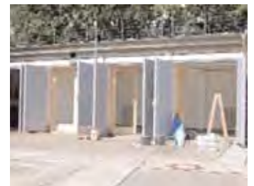
Umbau von Garagen zu Ausstellungsflächen, Mai 2006
