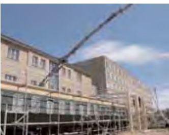
Errichtung des Schutzdaches für den Gefangenensammeltransportwaggon (GSTW), 2006
