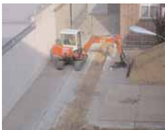
Bauarbeiten im Hof der Gedenkstätte vor dem Eingang zum "U-Boot" (re.) und der Fahrzeugschleuse (links oben)
