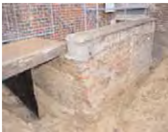
Fundamentisolierung am Altbau
