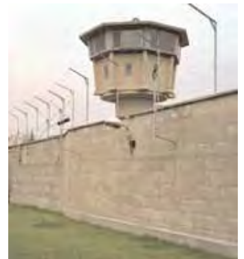
Wachturm an der Lichtenauer Straße
