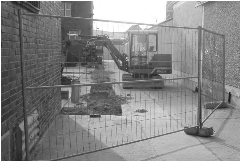
Bauarbeiten im Hof der Gedenkstätte vor dem Eingang zum "U-Boot", dem ehemaligen Kellergefängnis
