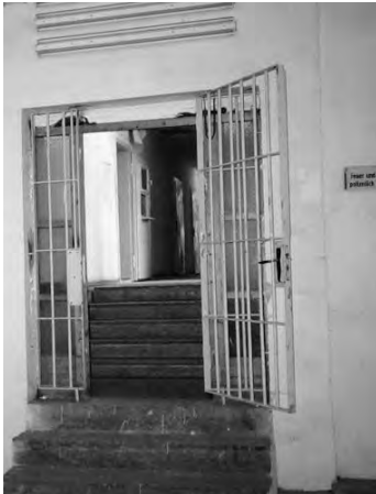
Empfangsschleuse und Eingang zum Zellenneubau
