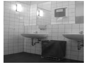
Ausbau der sanitären Anlagen
