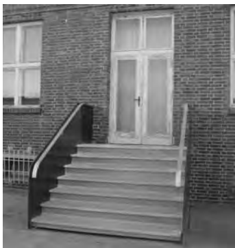
Provisorische Treppe zur Schaffung von Fluchtwegen
