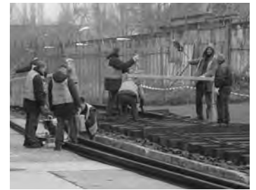
Mitarbeiter der BVG beim Aufbau des Gleisbettes für den Gefangenenwaggon
