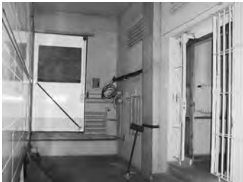
Schleuse im Neubau
