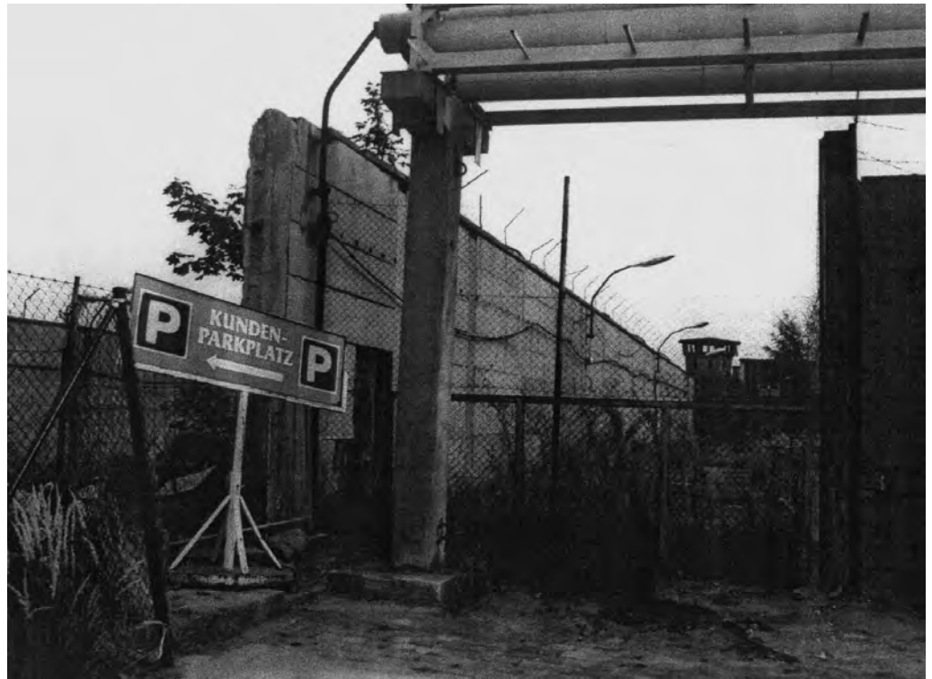
Umfriedungsmauer der leer stehenden Untersuchungshaftanstalt Anfang der neunziger Jahre
