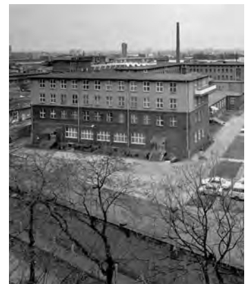
Das Gebäude der ehemaligen Großküche, dessen obere Etagen später durch das MfS aufgestockt wurden
