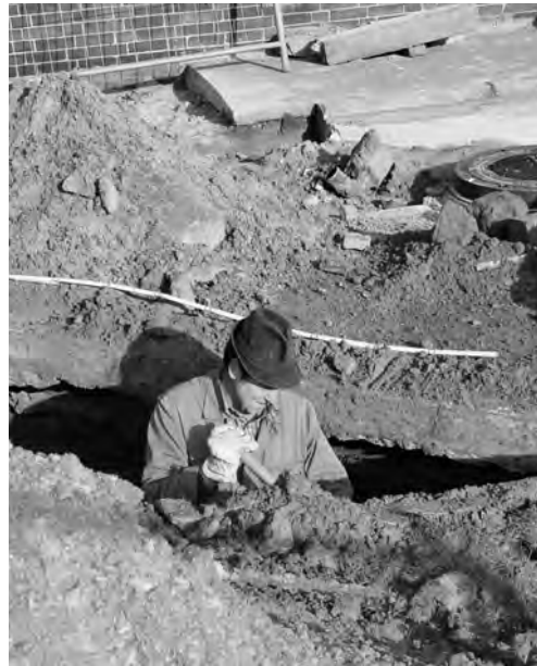
Erneuerung der Rohrleitungen
